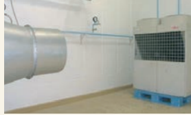
اختبار قوة تحمل الوحدة الخارجية عند الامطار Water shower testing
