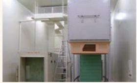
اختبار تدفق الهواء Airflow testing
